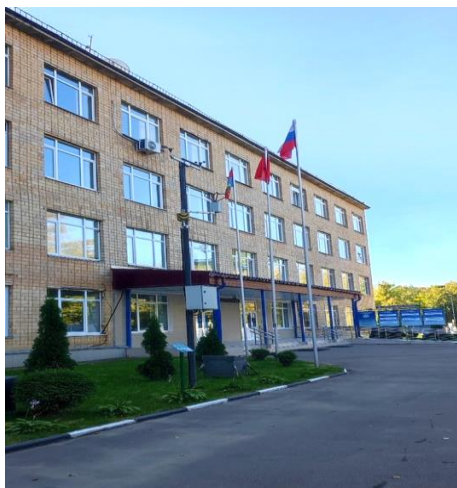
Фото 3 – здание Московского гидрометеорологического техникума
